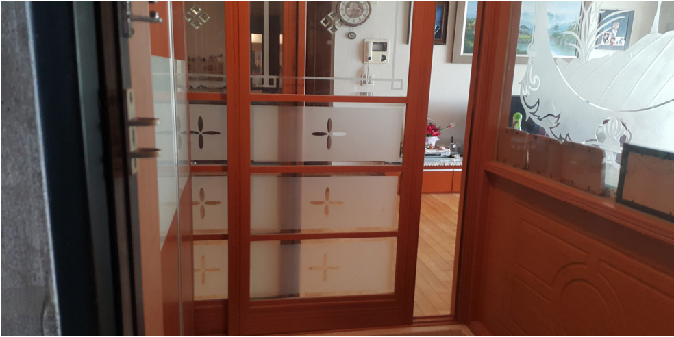
〈사진 10-2〉 수세에너지 유출 막는 현관의 중문 설치 사례
