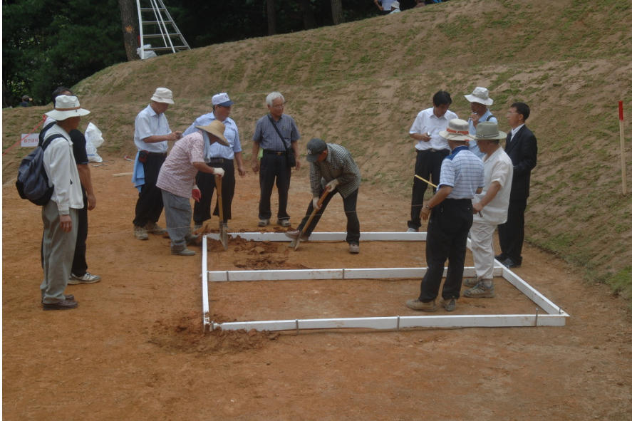
〈사진 7-7〉 김대중 전대통령 묘역의 광중 파는 나무틀 설치
