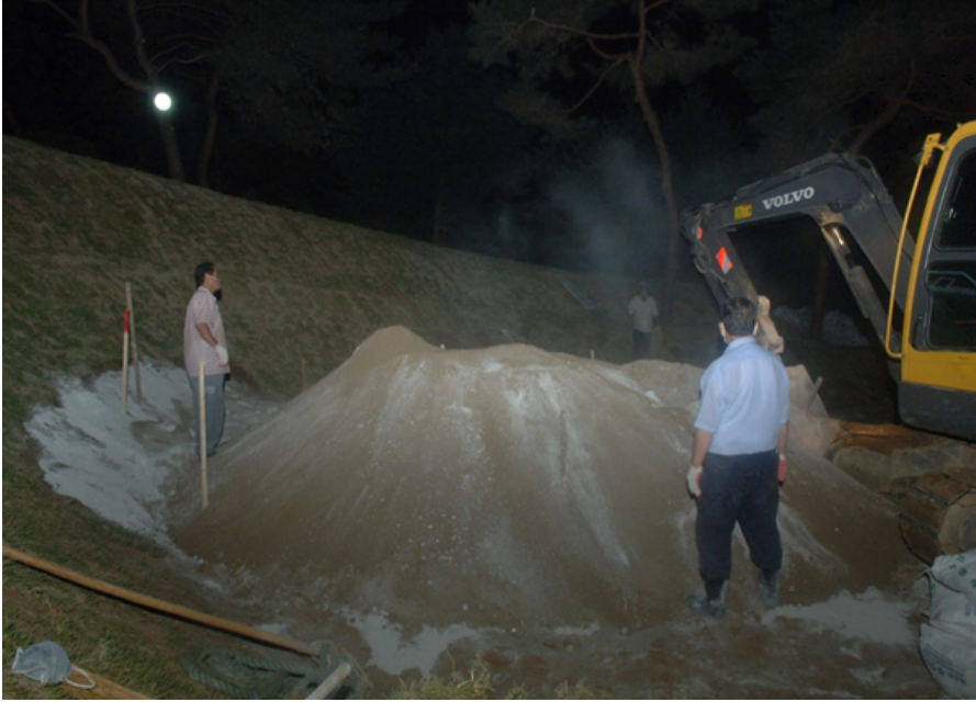
〈사진 7-26〉 봉분 설치 작업(생석회를 섞어서 방수)
