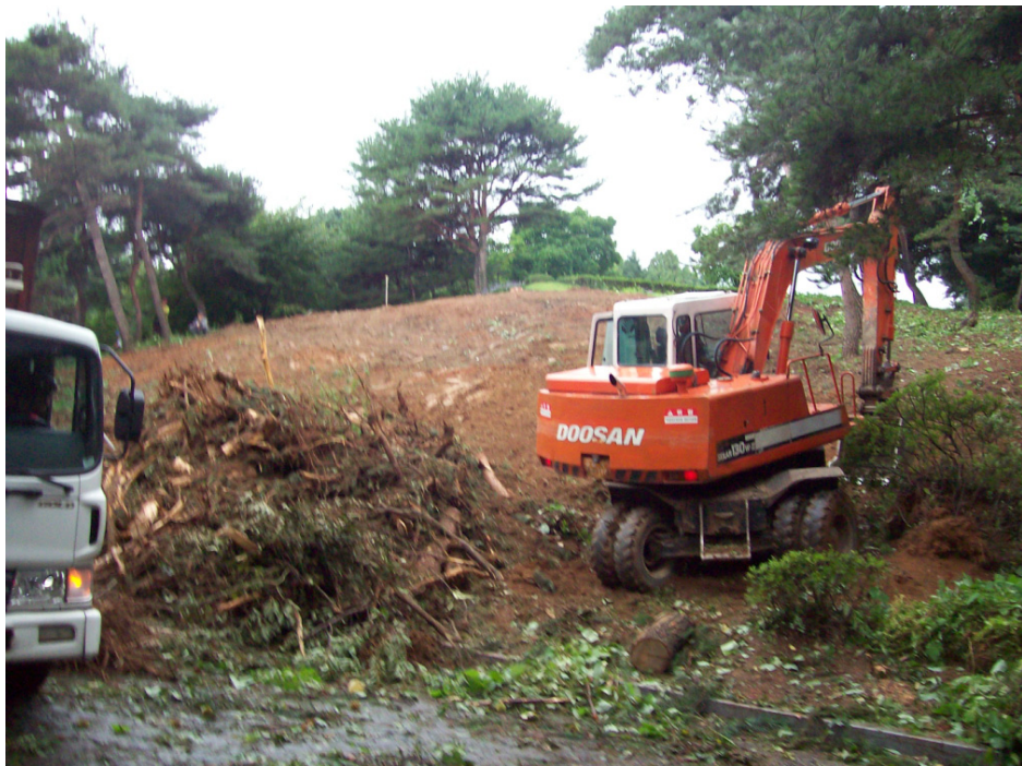
〈사진 7-4〉 국립서울현충원 내 안장지 수목 제거
