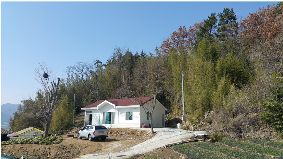
〈사진 8-2〉 전원주택 완성(전남 해남군 산이면 산두길 207-5번지)
