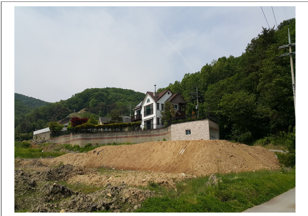
〈사진 8-4〉 수세에너지 이탈하는 대문(사진 좌측 상류에서 우측 하류로 시냇물이 흐름, 물이 빠져 나가는 하류 쪽에 대문과 차고를 설치하여 집안의 수세에너지가 이탈함)
